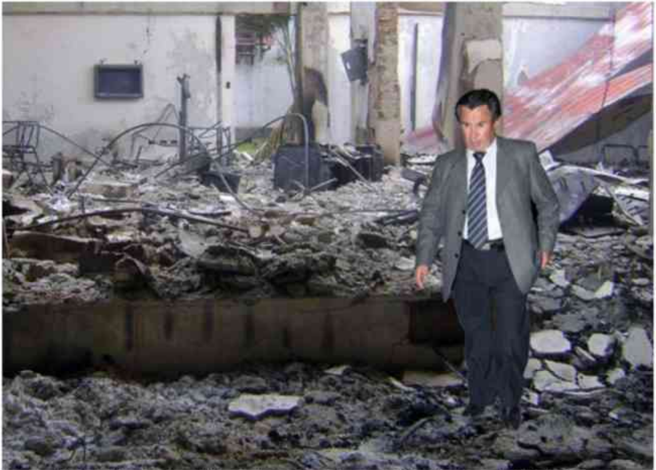
El doctor Hugo Molinedo Valencia observó los daños en el Módulo Básico de Justicia de Bagua
